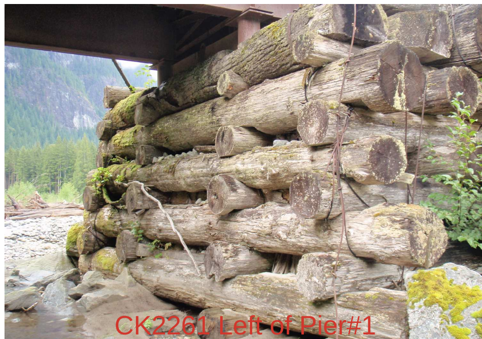
CK226 Pier#1 from...
